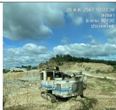
รูป AG การเจาะรูระเบิดจะต้องติดตั้งเครื่องมือตัดฝุ่นที่บริเวณหัวเจาะ
